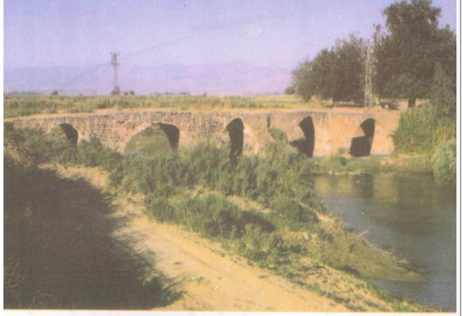
Resim 13. Taş Köprü (Dana Ahmetli Köyü, 16. yüzyılda yapıldığı sanılmaktadır.)
